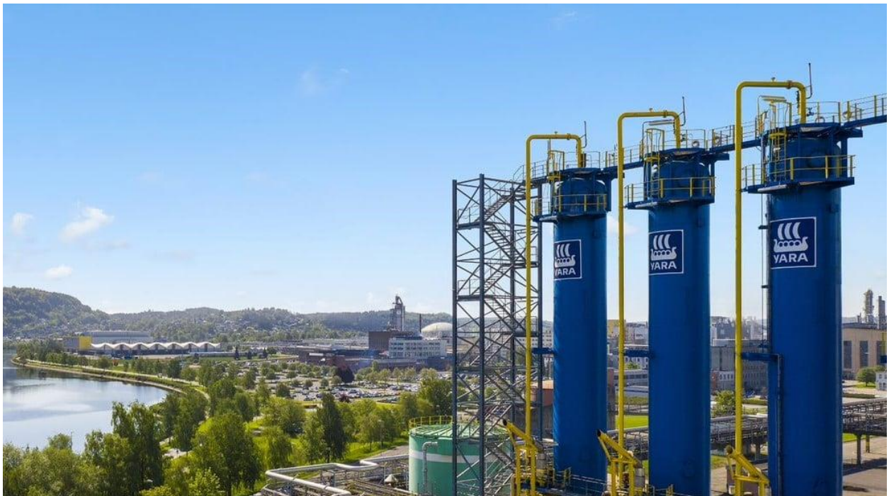
Yara construit actuellement avec Linde Engineering une centrale à hydrogène pour alimenter son usine d'ammoniac à Porsgrunn.
